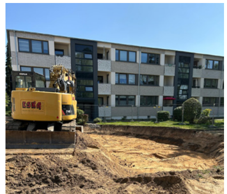
Bau Eisspeicher Erikahof, Hyazinthenweg
